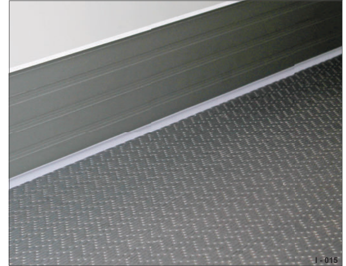
Abb. 19 in plaats van houten vloer, met aluminium schuurbescherming
