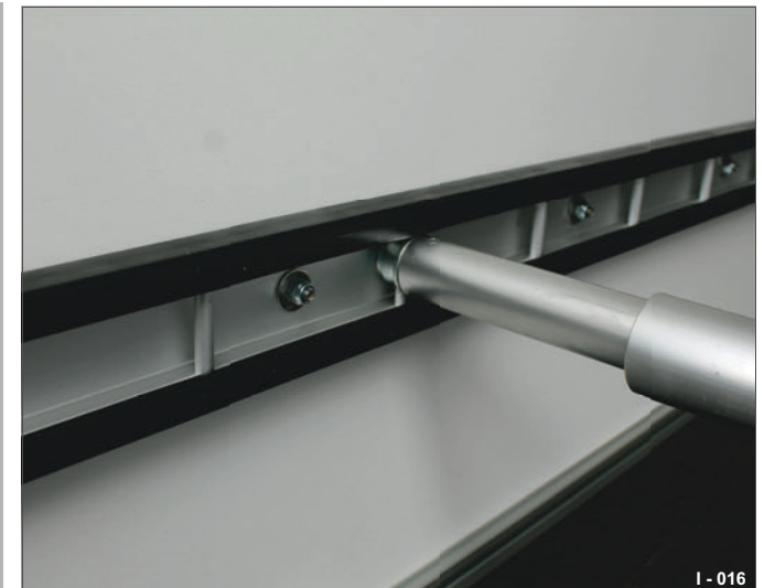
Abb. 25 vastgeschroefd op sandwichwand
