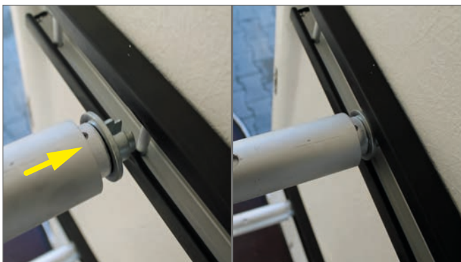
Mise en place des embouts
